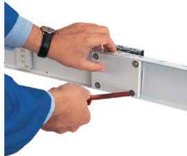
Bild 1-3 Herstellen einer sicheren Verbindung
